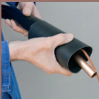
Montarea terminalului de strângere
