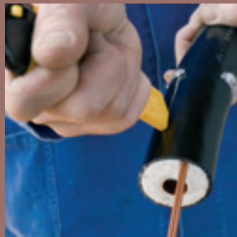
Îndepărtarea mantalei exterioare
